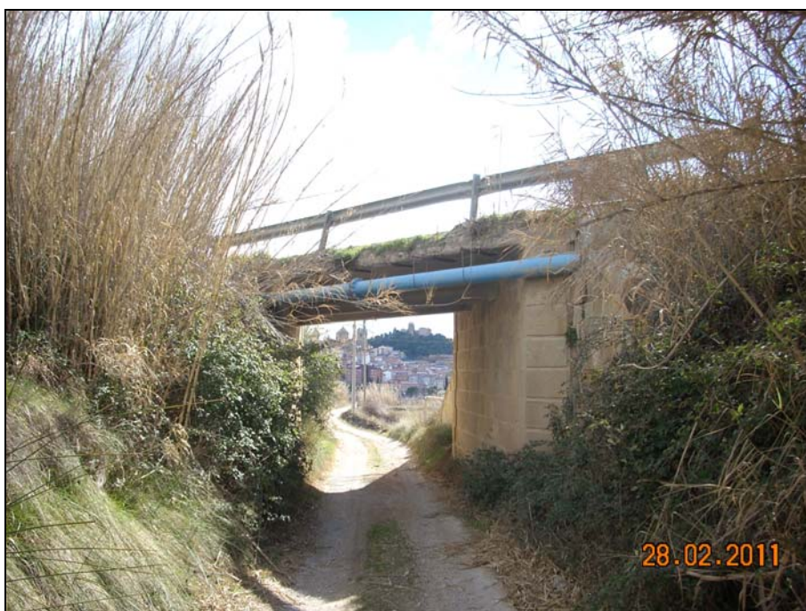
Tubo de abastecimiento de agua potable a su paso por el paso inferior
