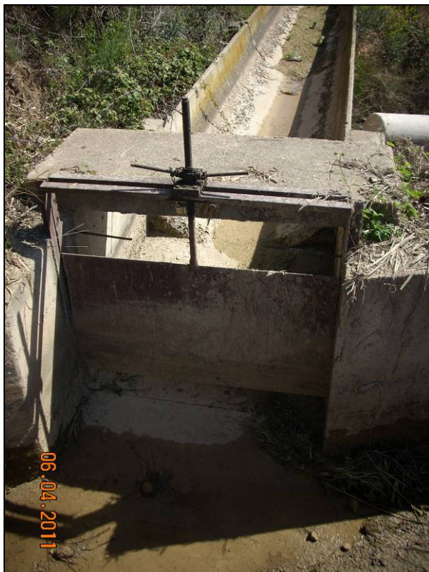
Compuerta para canal de derivación, ubicado justo antes del arquetón de entrada del sifón de la N211.
