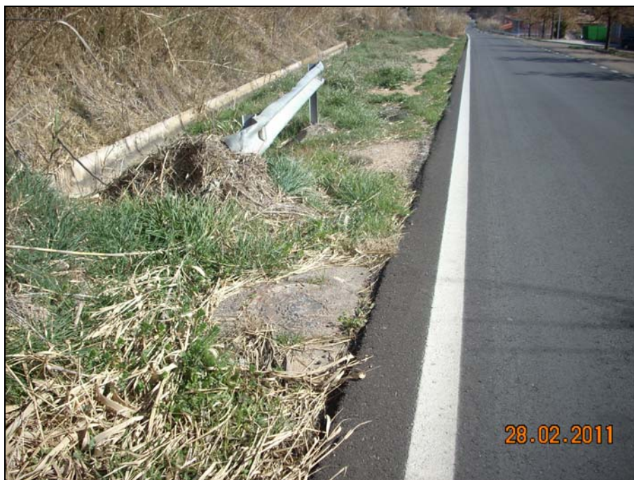
A la izquierda se observa acequia existente a reponer. En primer término se observa una arqueta perteneciente a la conducción de agua potable existente.
