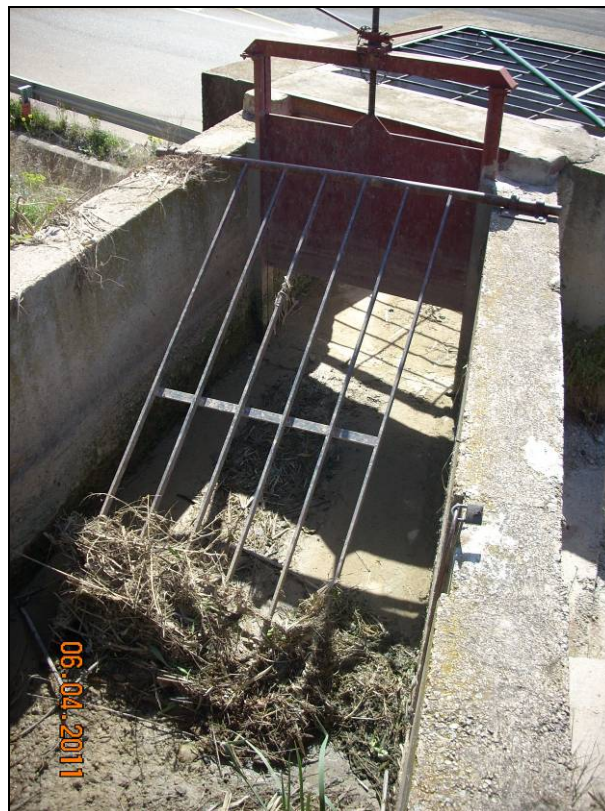
Reja de desbaste antes del arquetón de entrada al sifón de la N211.
