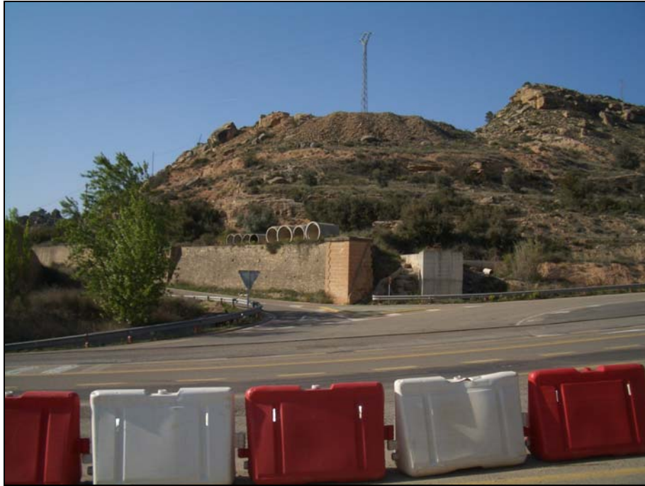
Vista de dos sifones y muro de piedra en zona de cruce con la N-211. El sifón de la derecha (hormigón) deberá ser repuesto.
