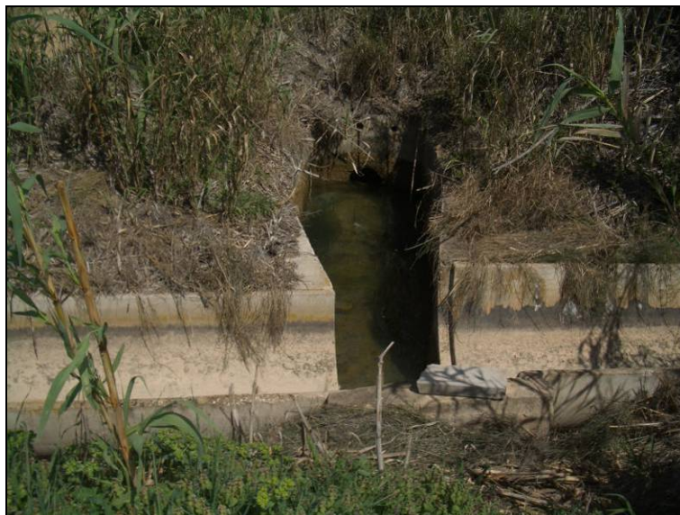
Ramal Norte, vista hacia el Norte, punto de entronque del tramo circular enterrado con el canal a cielo abierto del ramal Sur
