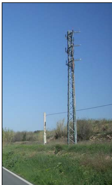
Ubicación de conversión aérea-subterránea de la red de media tensión existente (LAMT+LSMT)
