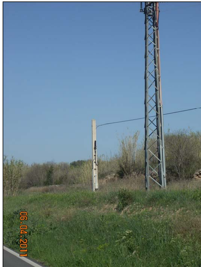
Vista de poste hormigón de telefonía y poste metálico de Media Tensión en la zona de actuación. Ambos a desplazar.
