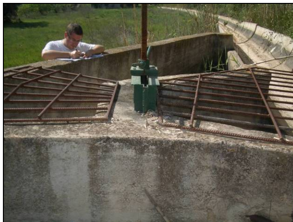
Ramal Norte, vista hacia el Oeste, infraestructura a reponer, donde se realiza la el cambio de sección y sentido de la acequia, pasando de sección semicircular a cielo abierto a circular enterrada.
